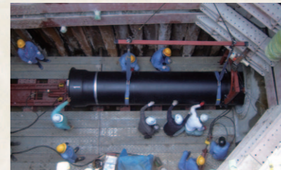
▲さや管推進工法施工状況
