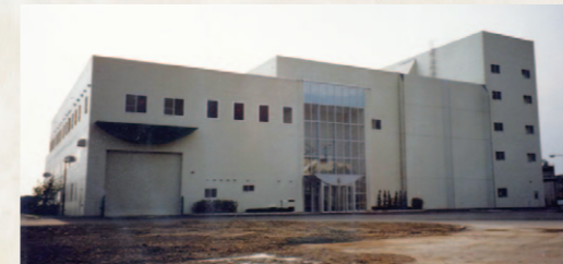
▲建屋設計をしたゴミ処理プラント
