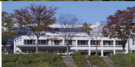
1966年竣工の旧1号館は、八草キャンパスで最も古い建物の1つ
