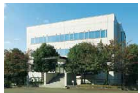
1992年 総合技術研究所竣工
