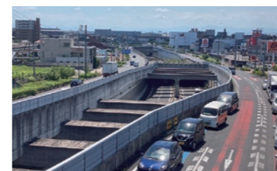
中部国際空港関連事業で手掛けた知多横断道路
