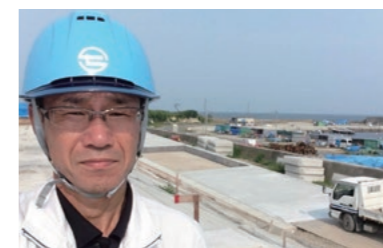
派遣先で行った七ヶ浜町防潮堤災害復旧工事
