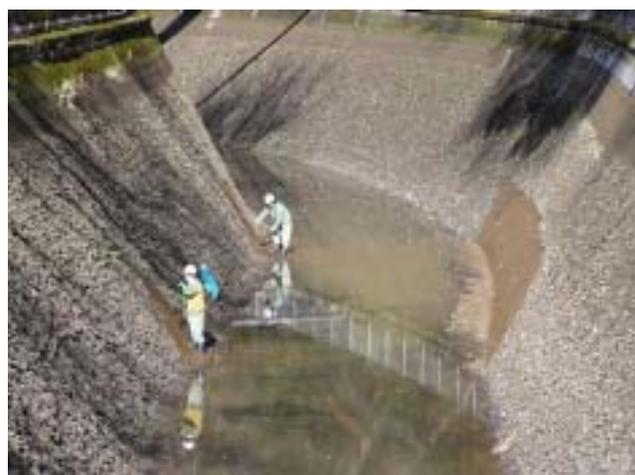
写真2 中部電力(株)越戸発電所導水路の壁面に固着しているカワヒバリガイ
