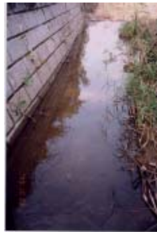
写真 7 未確認地点下流部（水際線）
