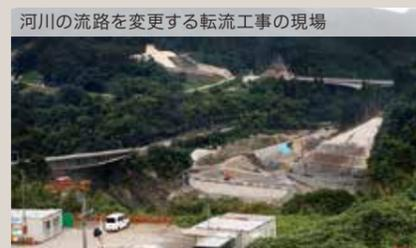
河川の流路を変更する転流工事の現場
